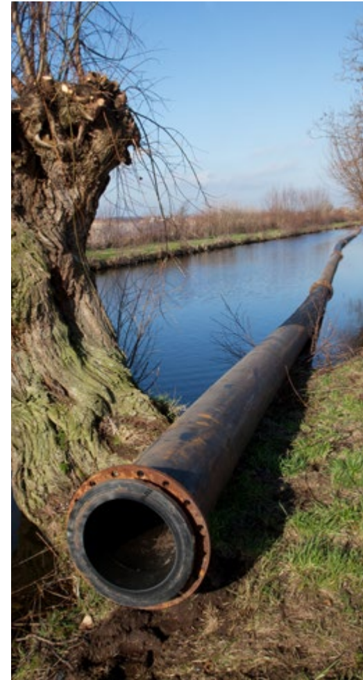
Het isoleren van de plas Klein Vogelenzang (aanleg van een stuw)
