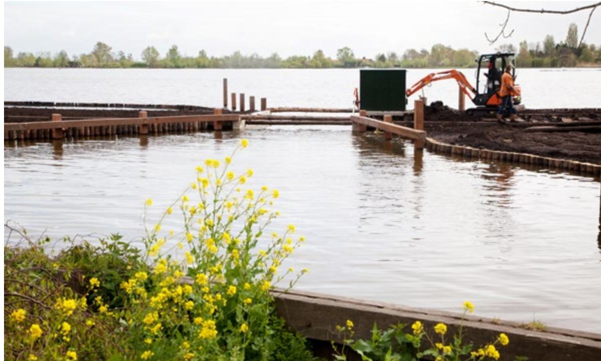
Het isoleren van de plas Sloene
